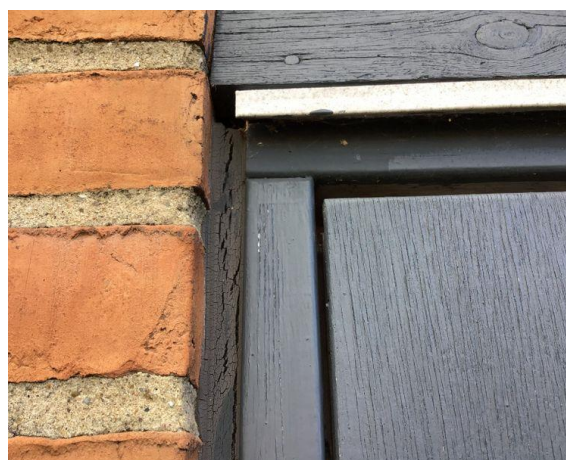
| Elastiske fuger fremstår nedbrudte.
