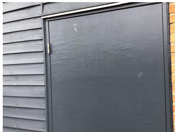
| Træværk fremstår flere steder slidt og med nedbrydning.
