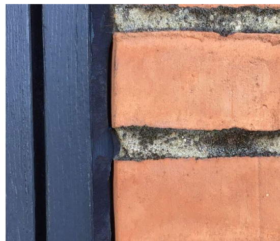
| Elastiske fuger fremstår nedbrudte.
