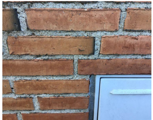
| Murværk med forvitrede fuger
