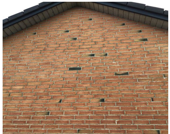
| Murværk med forvitrede fuger
